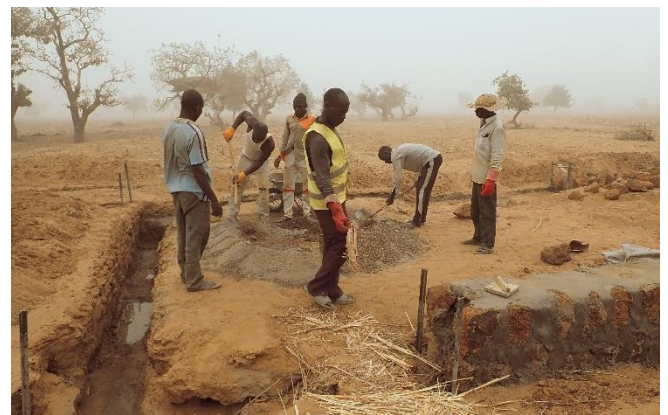
Travaux de fouilles pour ouvrage à Manni
